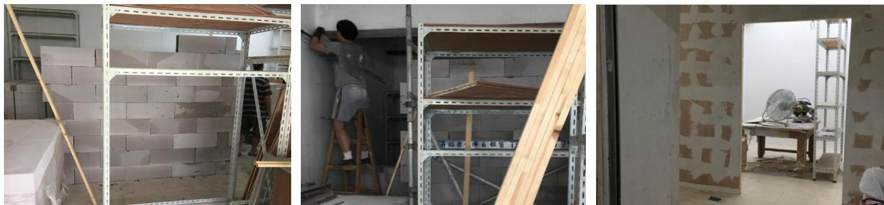
為要趕及在十天內把倉庫做好，讓迷你倉貨物能搬入，拆場後立即要拉好電線及砌起視像室的兩層隔聲磚牆，再建倉庫的圍牆、批灰、牆身與天花油漆、安裝空調等工程按序進行。
